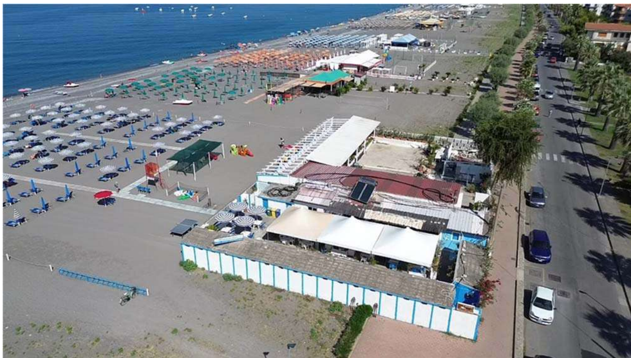
FOTO 12 Vista area demaniale direzione nord
