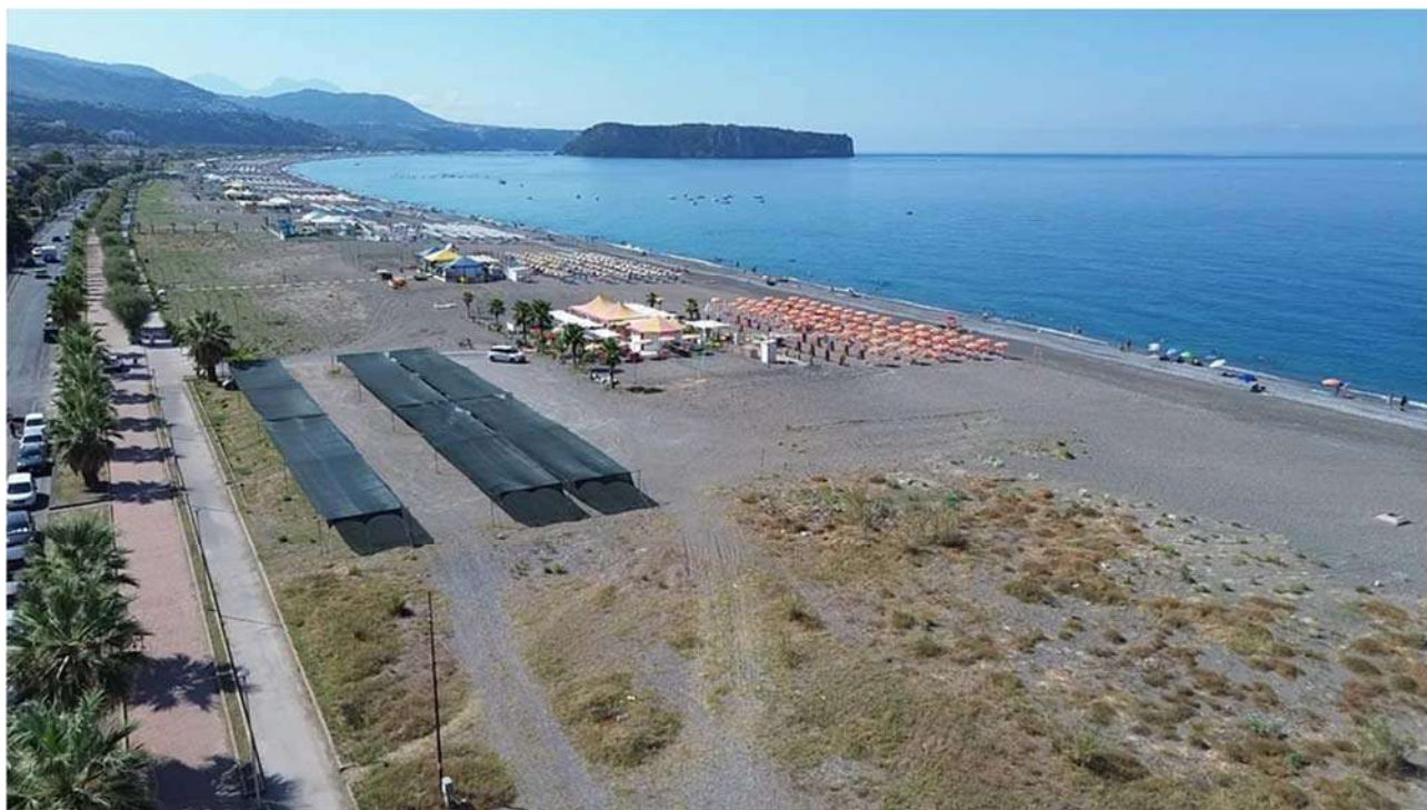
FOTO 16 Vista area demaniale da nord direzione sud
